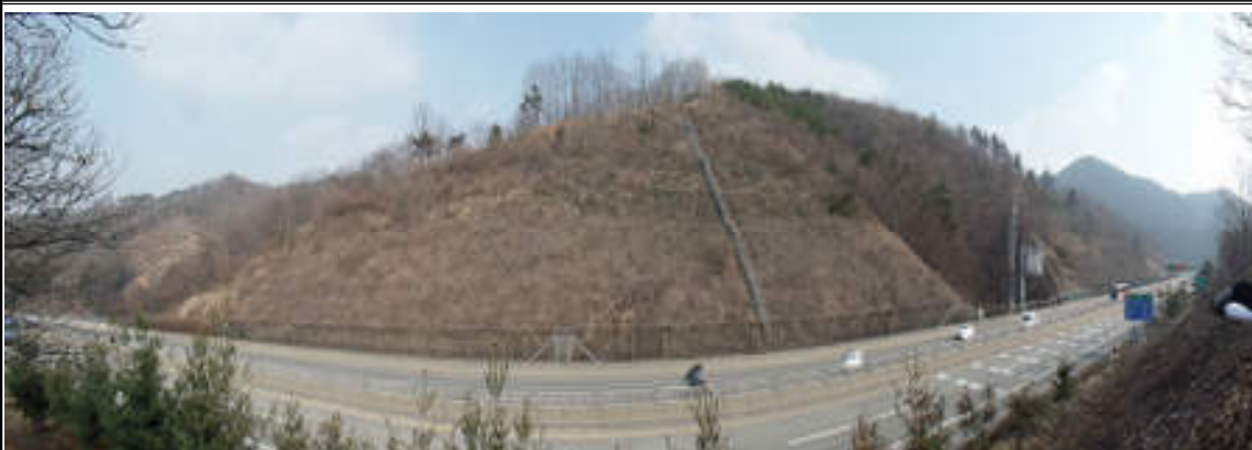
천안절토6 (순천기점 264.213 ~ 264.359 / STA. 2공구 STA. 7+129 ~ 6+983)
