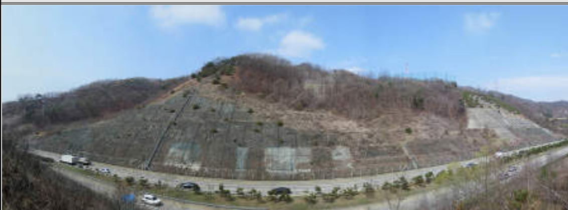
논산절토3 (순천기점 260.550 ~ 260.094 / STA. 2공구 3+590 ~ 4+046)
