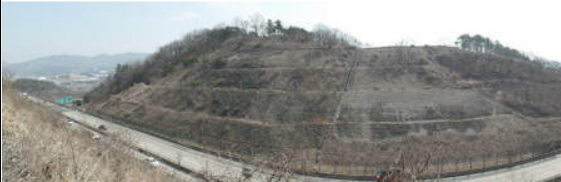
천안절토10 (순천기점 255.710 ~ 255.960 / STA. 2공구 8+430 ~ 8+180)
