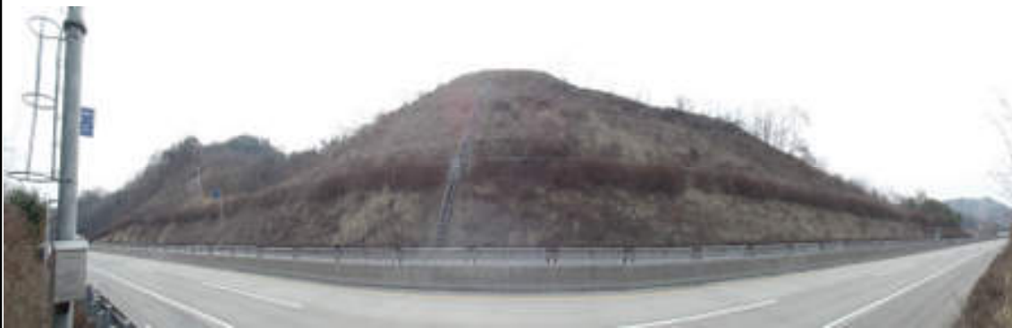
논산절토9 (순천기점 250.108 ~ 249.771 / STA. 3공구 4+922 ~ 5+259)
