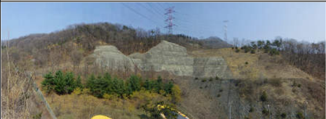
천안절토8 (순천기점 260.970 ~ 261.110 / STA. 2공구 3+170 ~ 3+030)
