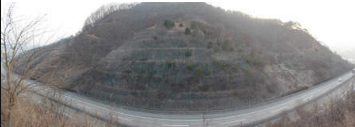
천안절토5 (순천기점 264.555 ~ 264.678 / STA. 1-2공구 6+808 ~ 6+685)
