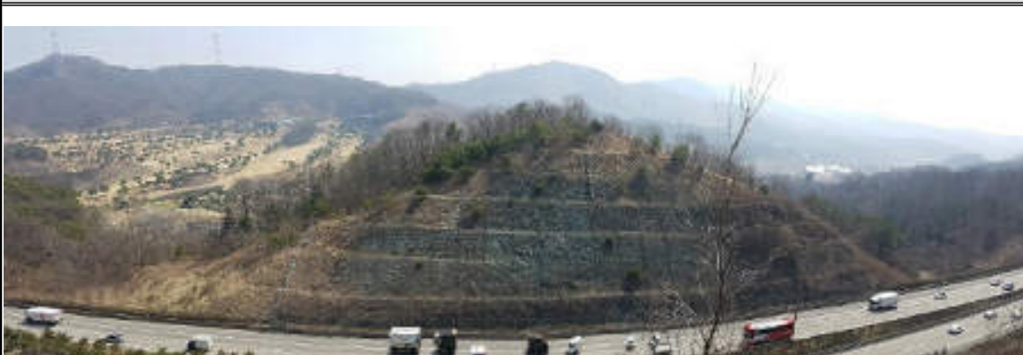
천안절토9 (순천기점 260.200 ~ 260.438 / STA. 2공구 4+028 ~ 3+790)
