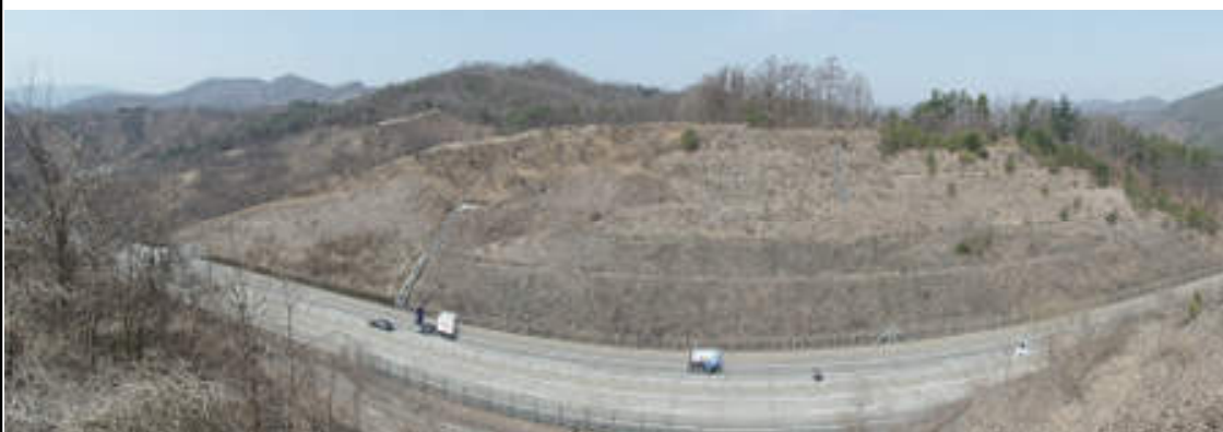
논산절토7 (순천기점 255.955 ~ 255.680 / STA. 2공구 8+205 ~ 8+480)
