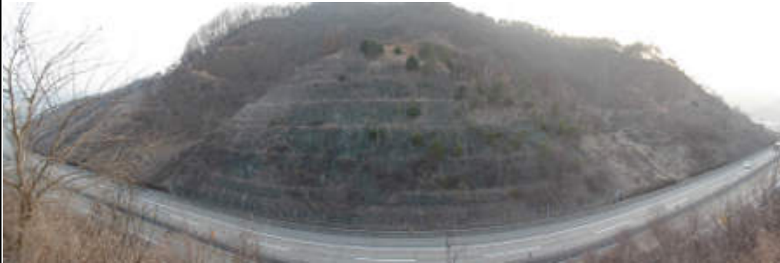
논산절토5 (순천기점 258.874 ~ 258.977 / STA. 2공구 5+380 ~ 5+510)
