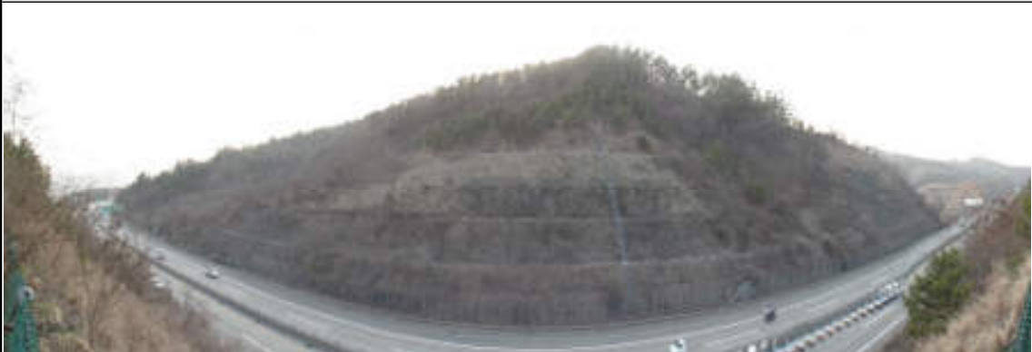
논산절토13 (순천기점 245.266 ~ 244.920 / STA. 3공구 9+766 ~ 10+112)
