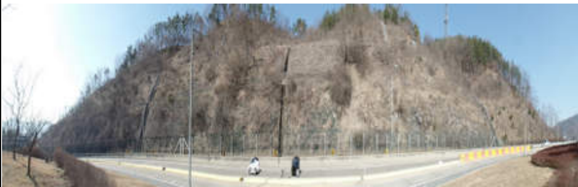
논산절토6 (순천기점 257.614 ~ 257.339 / STA. 2공구 정안IC R-C 0+430 ~ R-A 0+940)
