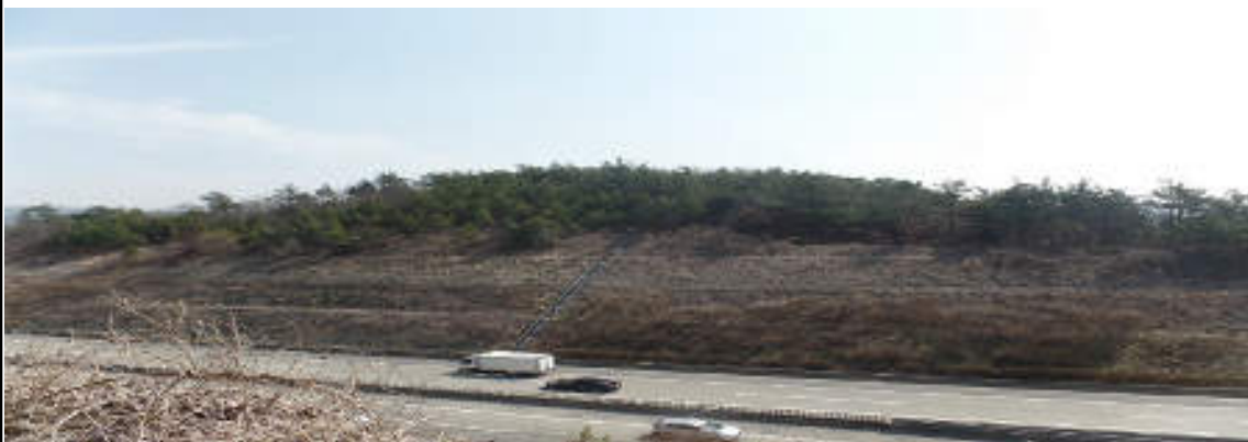
논산절토11 (순천기점 247.490 ~ 247.210 / STA. 3공구 7+524 ~ 7+804)
