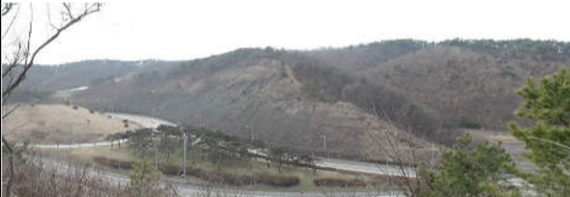
논산절토2 (순천기점 274.175 ~ 273.886 / STA. 1-1공구 남천안IC R-C 0+191 ~ R-A 0+481)
