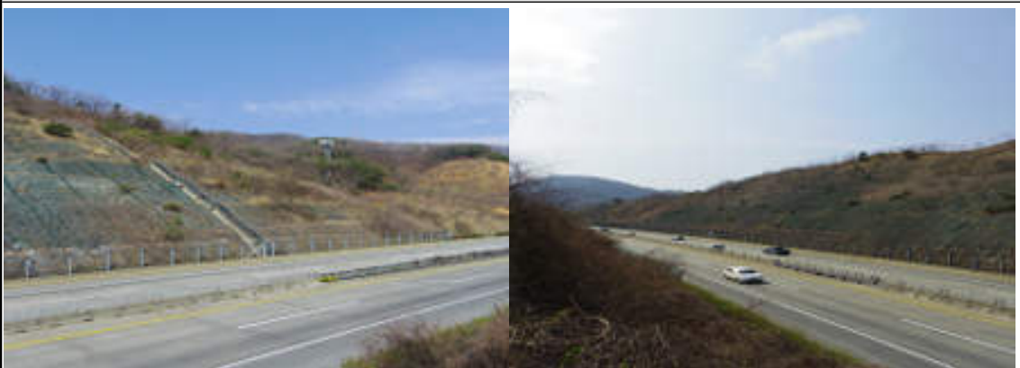
논산절토4 (순천기점 260.049 ~ 259.580 / STA. 2공구 4+046 ~ 4+560)
