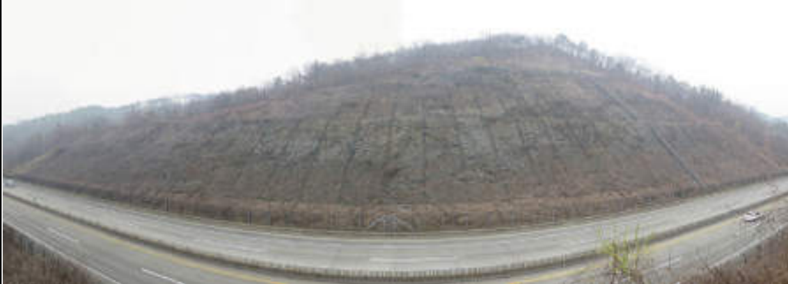
천안절토4 (순천기점 264.748 ~ 264.988 / STA. 1-2공구 6+530 ~ 6+290)
