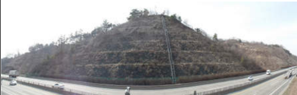
논산절토8 (순천기점 255.137 ~ 254.993 / STA. 3공구 STA. 0+024 ~ 2공구 8+982)
