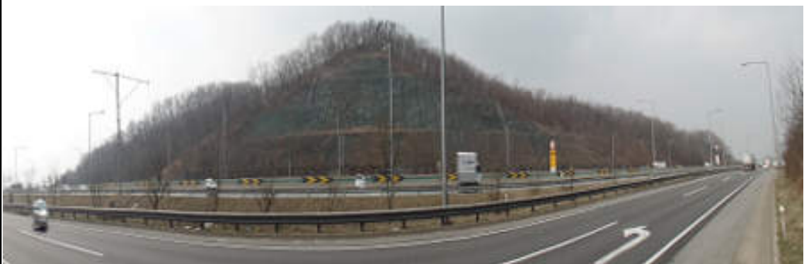
논산절토1 (순천기점 276.727 ~ 276.489 / STA. 1-1공구 천안JC R-A 0+462 ~ 0+700)
