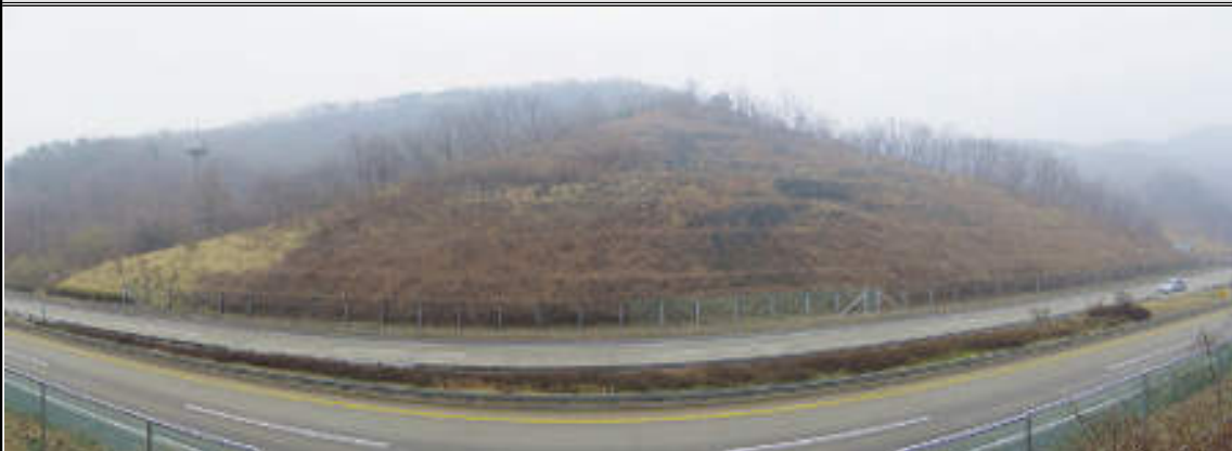
천안절토7 (순천기점 263.840 ~ 264.020 / STA. 2공구 0+370 ~ 0+190)
