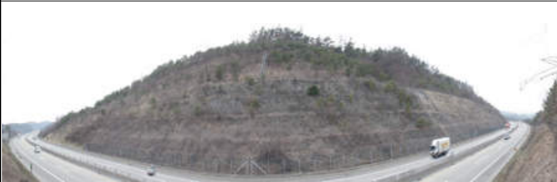
논산절토10 (순천기점 248.903 ~ 248.400 / STA. 3공구 6+117 ~ 6+620)
