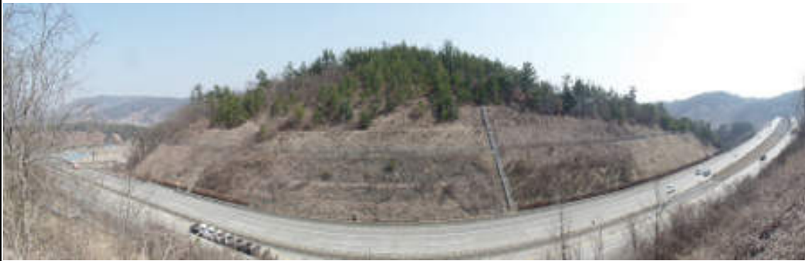
천안절토11 (순천기점 247.214 ~ 247.490 / STA. 3공구 7+800 ~ 7+544)
